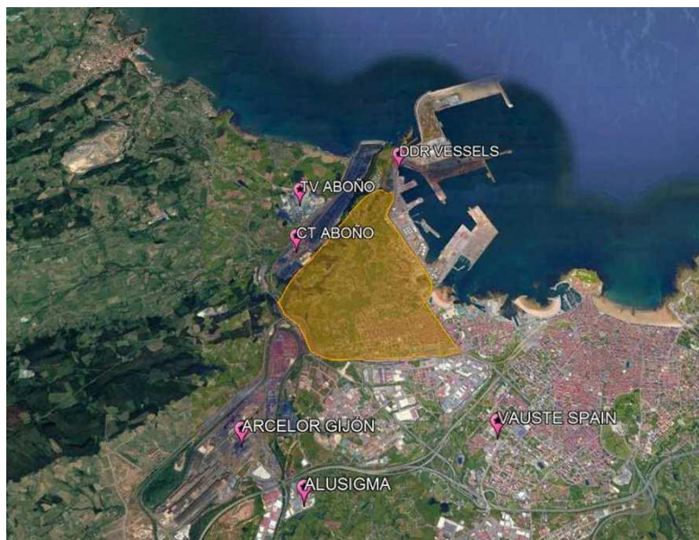
Figura 29. Instalaciones con Autorización Ambiental Integrada consideradas como agentes implicados (Fuente de la imagen: Google Earth).
