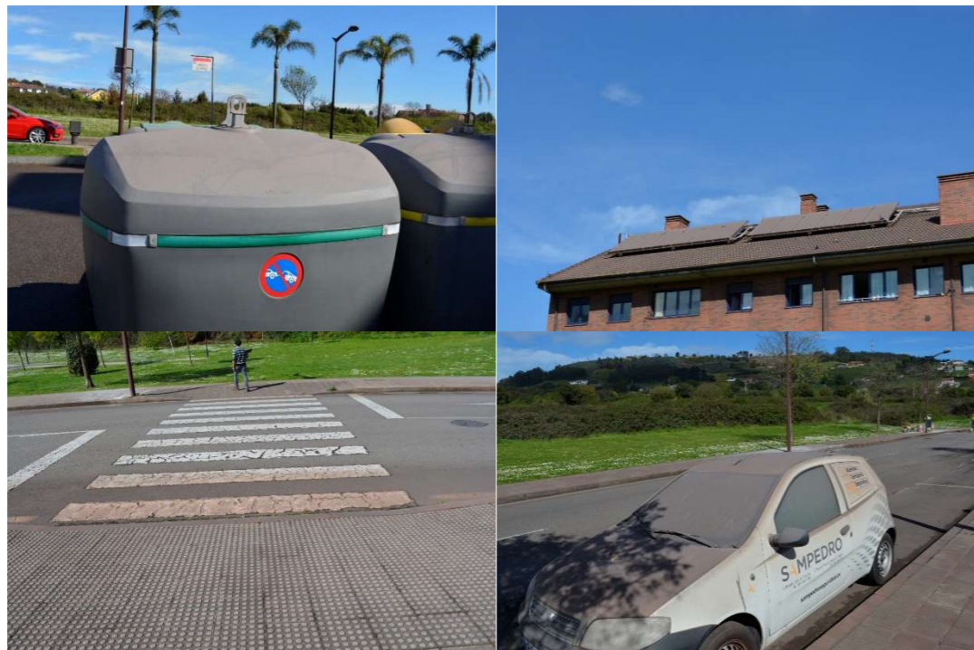
Imagen 22. Detalle de existencia de óxido de hierro en distintas superficies del entorno del Parque El Lauredal.
